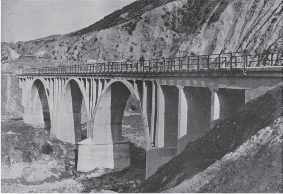
Sivas-Erzurum demiryolu güzergâhını süsleyen zarif eserlerden, bir betonarme köprü
