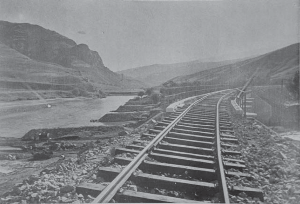
Fırat kenarında tahkim mahmuzları
