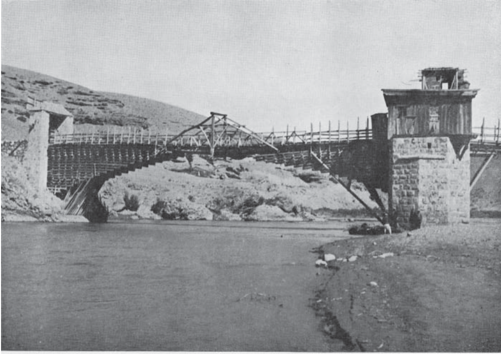
Pingân boğazındaki eski ahşap köprü
