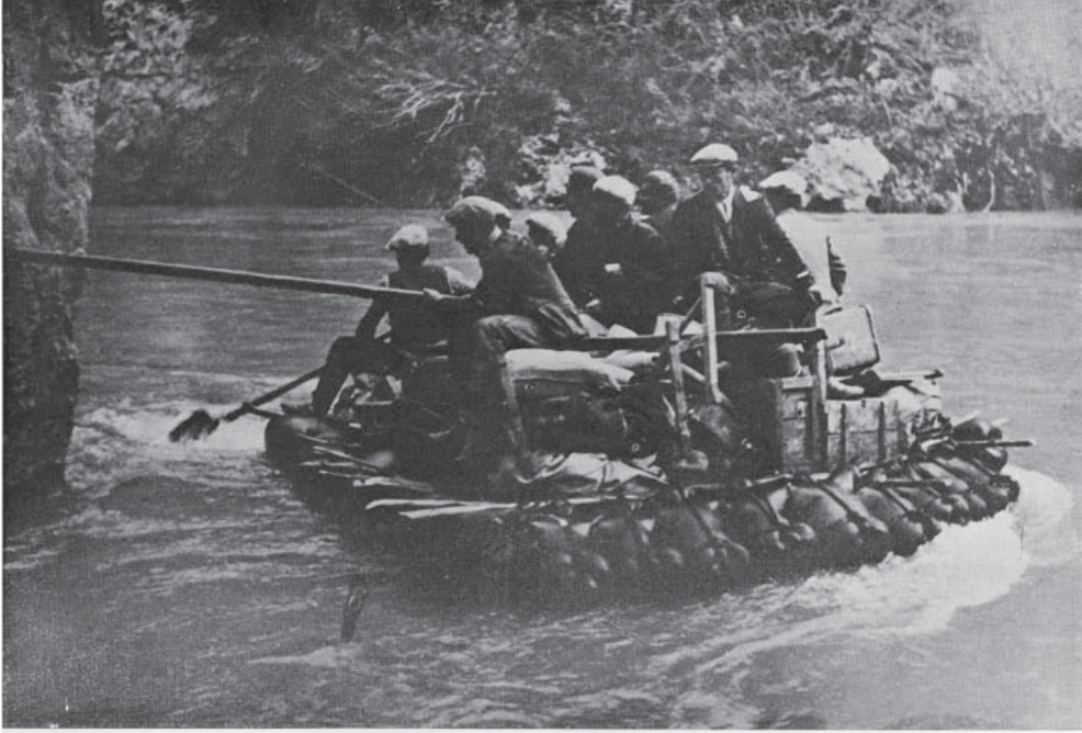
Fırat üzerinde geçirilmiş tulumlarla amele nakliyatı
