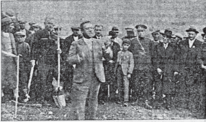
Divrik istasyonunun temeli atılırken
