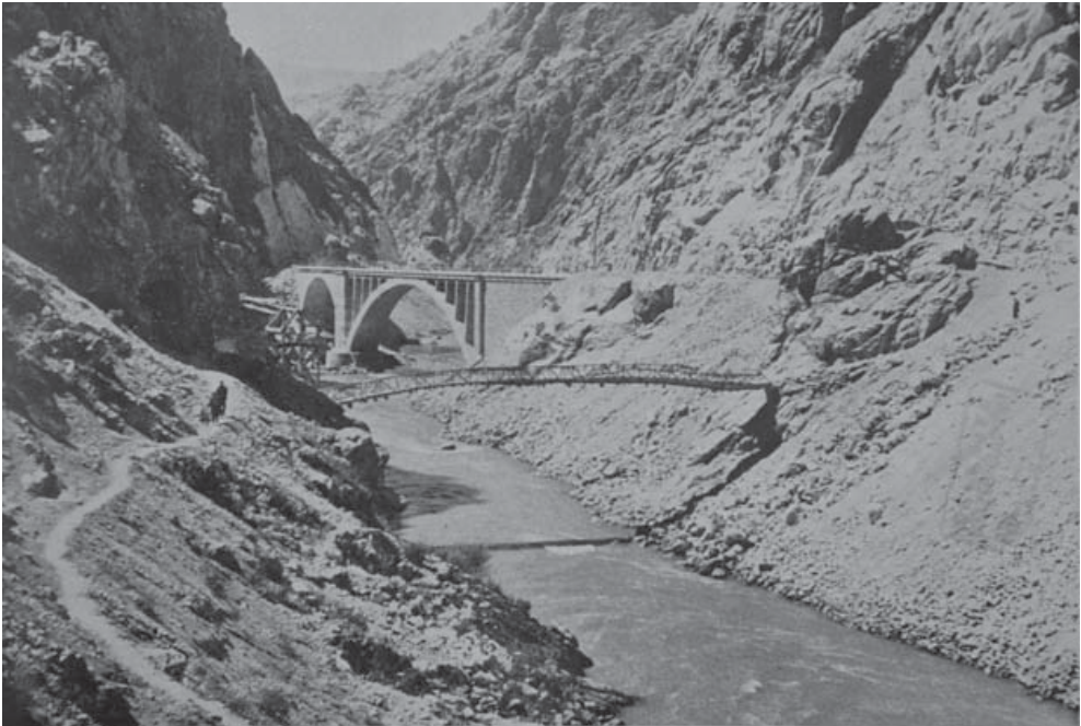
Atma boğazı Büyük beton arme köprü ile ahşap servis köprüsünün uzaktan görünüşü
