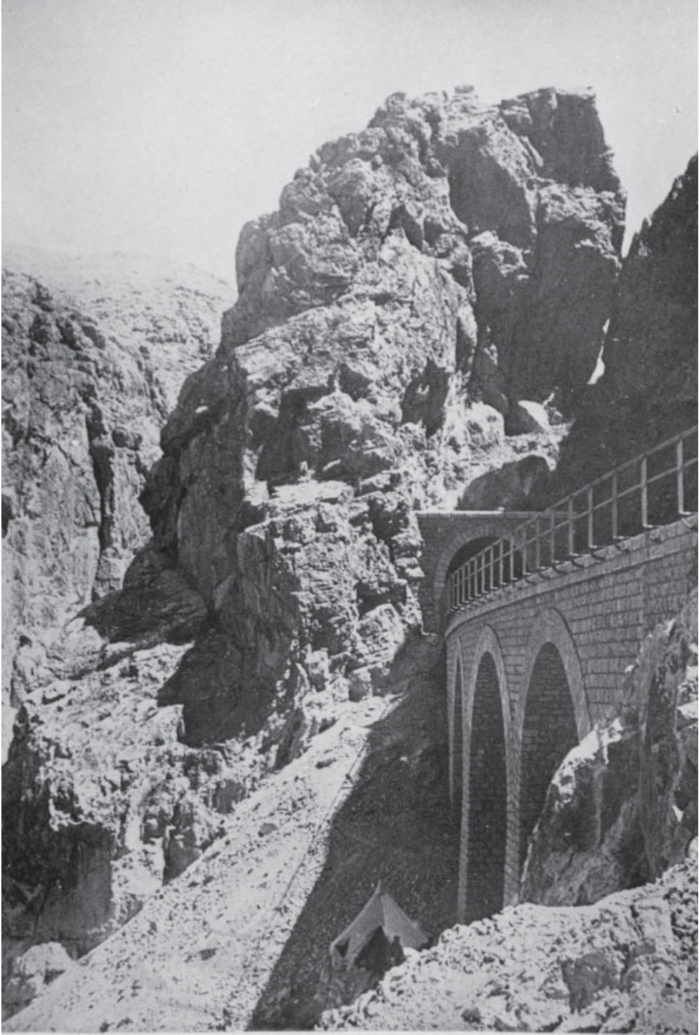
Atma boğazında tünel ve köprü
