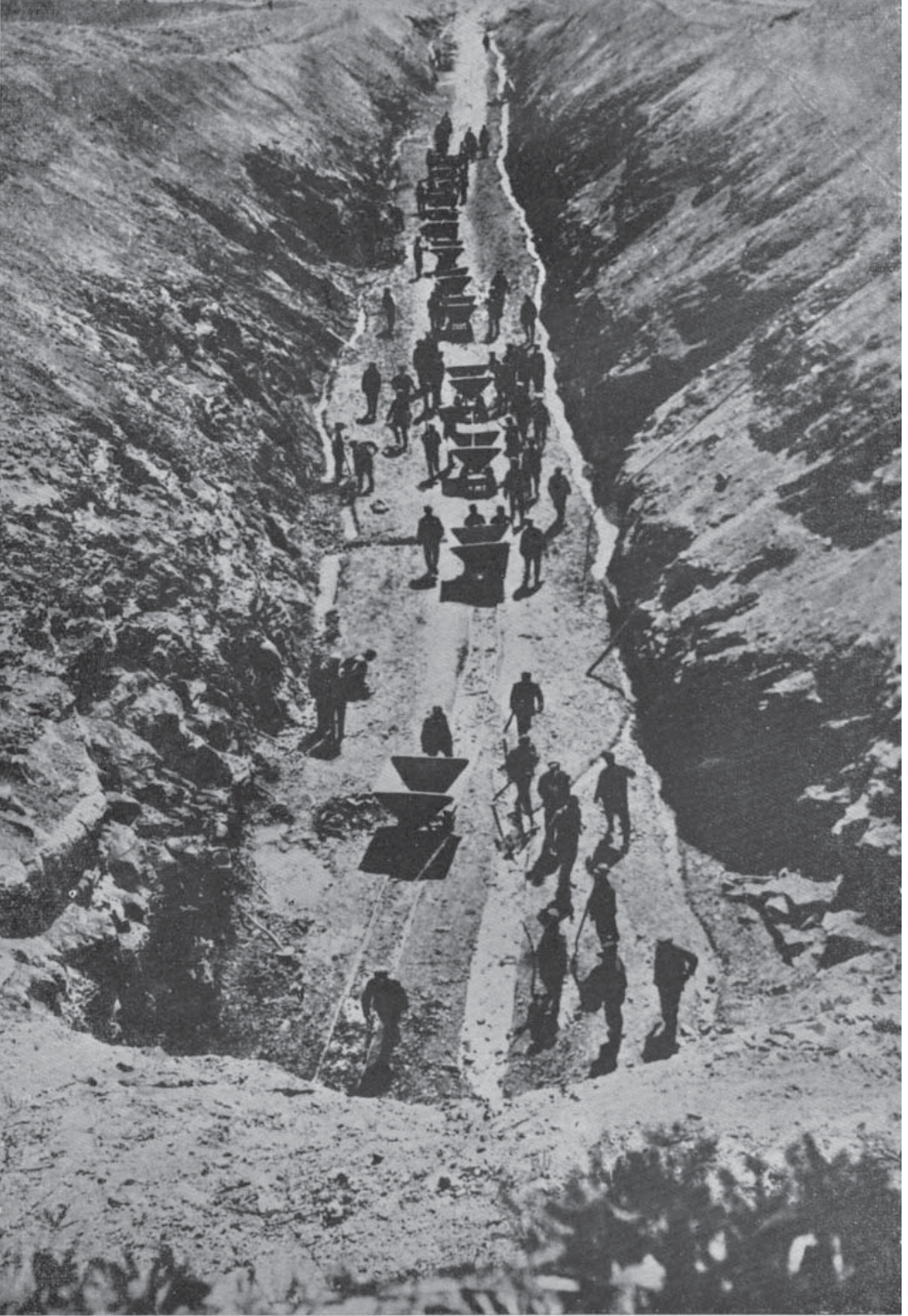
Millî demiryollarımızgüzergâhındaki büyük yarmalardan birinin açılma ameliyatı
