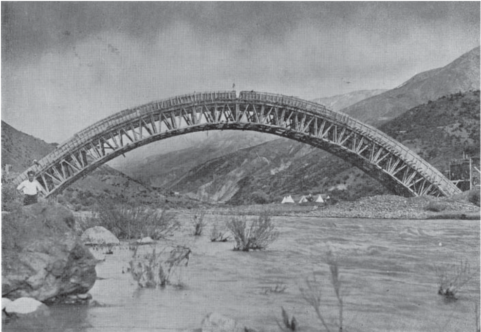
386+700 üne3 kilometrede şose üzerinde 68,00 metre açıklığında betonarme köprü inşaat halinde
