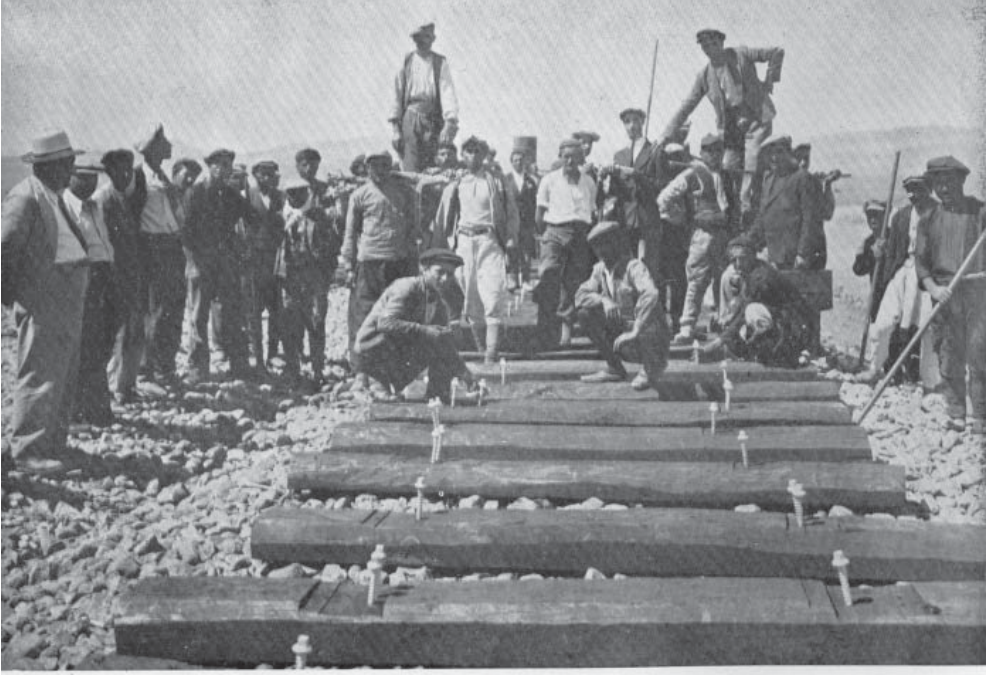
Ahşap traverslerin vidalanması
