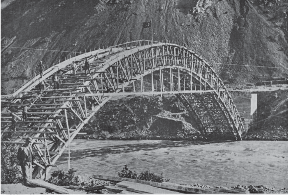
Aynı köprüden başka bir görünüş
