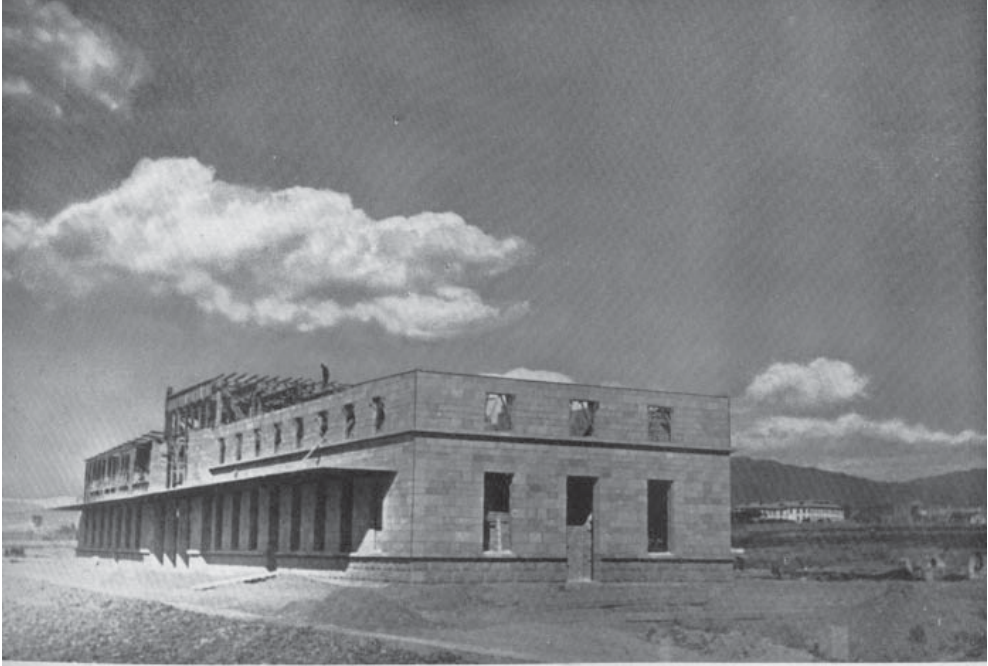
Erzurum garının yolcu binası inşaat halinde
