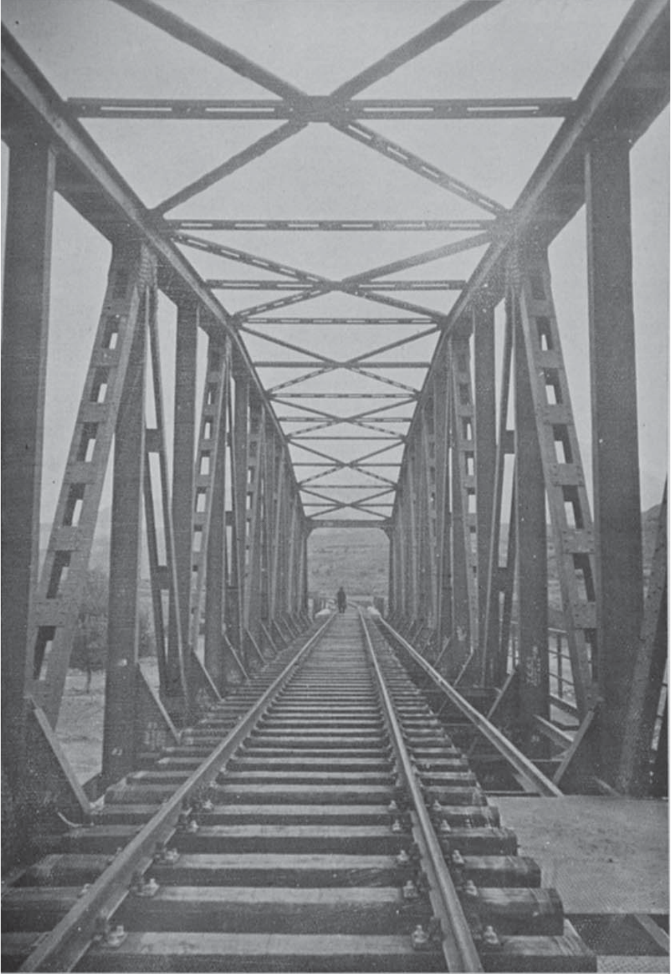
Fırat üzerine kurulmuş abidelerden (60) metre açıklığında bir demir köprü
