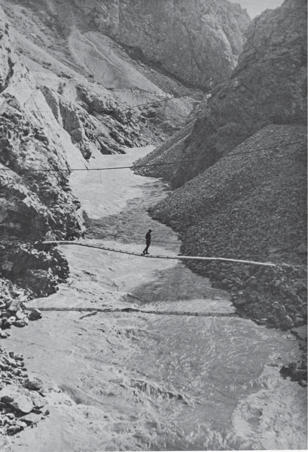
Fırat üzerine uzatılmış asma servis köprüsü
