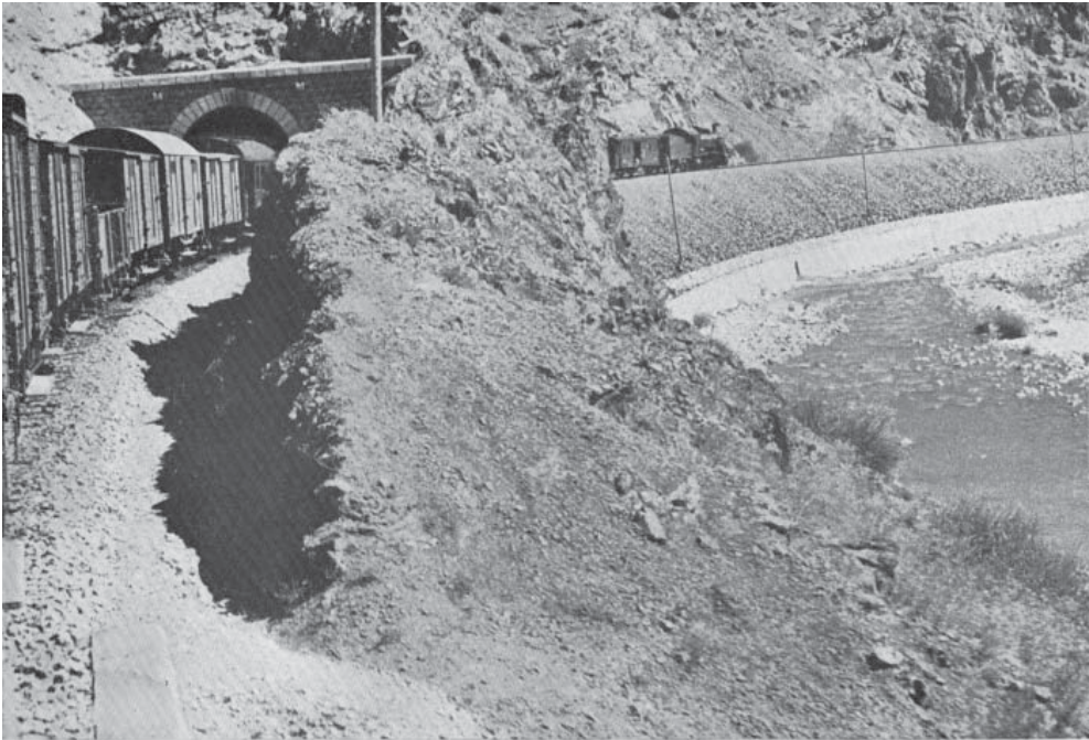
Sivas-Erzurum demiryolu güzergâhı ile Fıratı müdafaa ve tahkim inşaatından istinat duvarları
