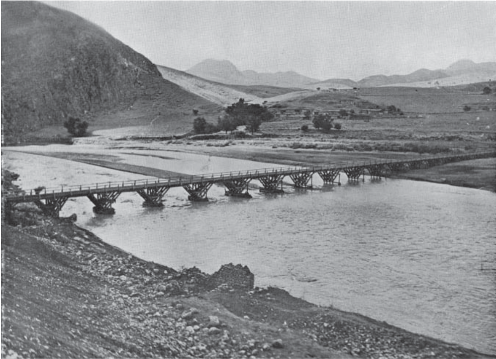
Bağıtaş istasyonunun karşısında servis köprüsü
