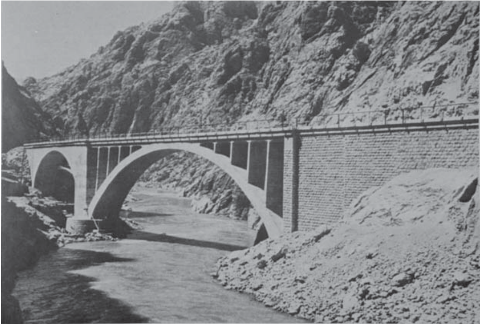
Atma boğazında (55×25) metre açıklığında betonarme köprü
