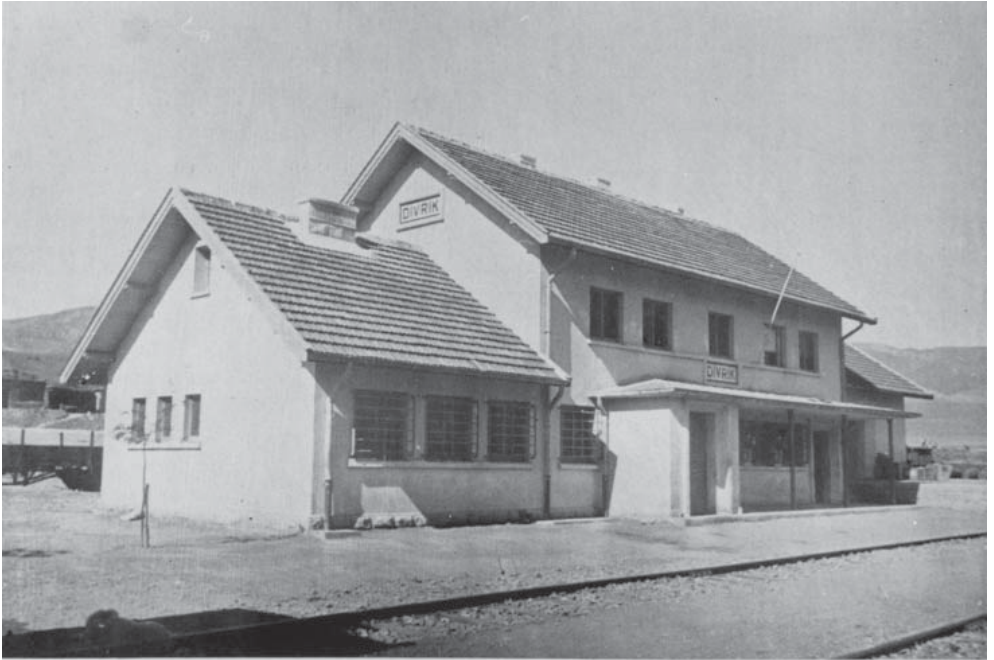
Divriğ istasyonu yolcu binası
