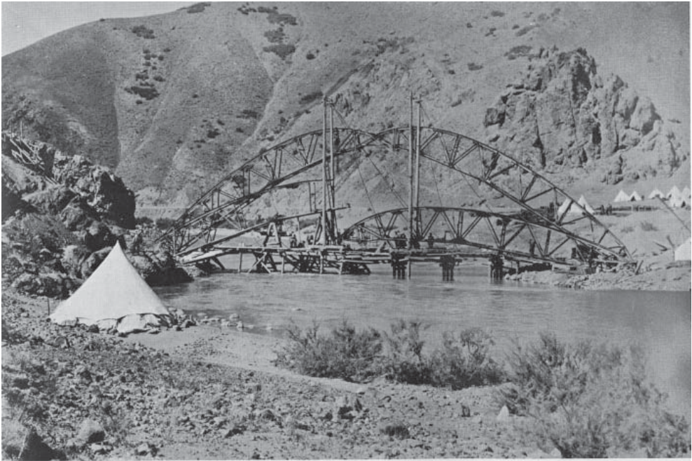
Sivas-Erzurum demiryolu güzergâhında 374 üncü kilometrede bir köprü inşaat halinde
